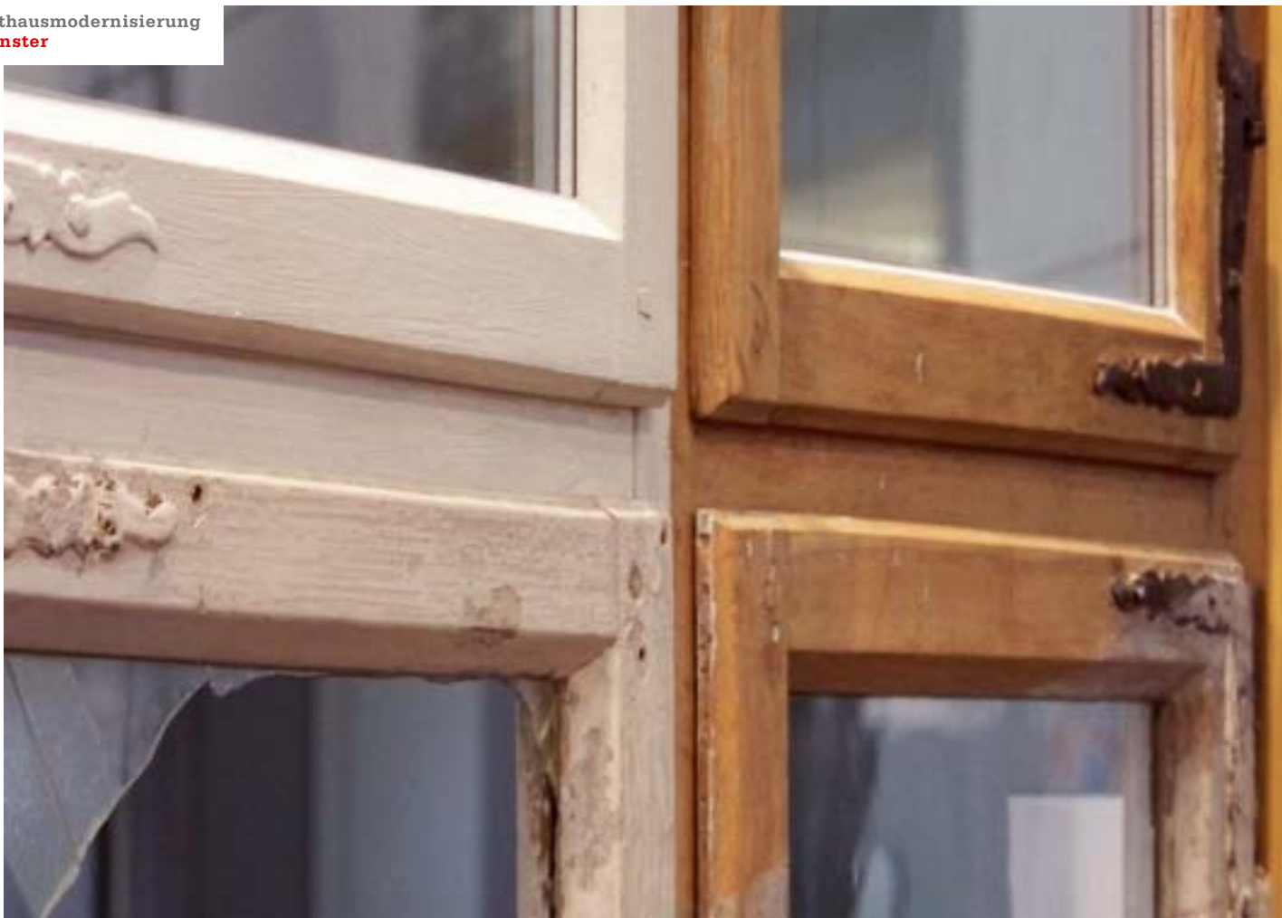
Die unteren alten Flügel sind noch in einem schlechten Zustand und teilweise mit einer Einfachverglasung ausgestattet. Die oberen wurden schnell und unproblematisch mit dem neuen 8 mm dicken Histo-Fein-8-Isolierglas versehen, das die Energiebilanz deutlich verbessert.
