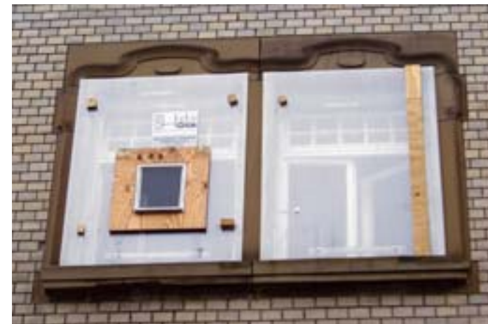
Um das Gebäudeinnere vor Witterungseinflüssen zu schützen, wurde nach der Fensterflügel-Demontage die Öffnung mit einer Kunststoffstegplatte geschützt.
