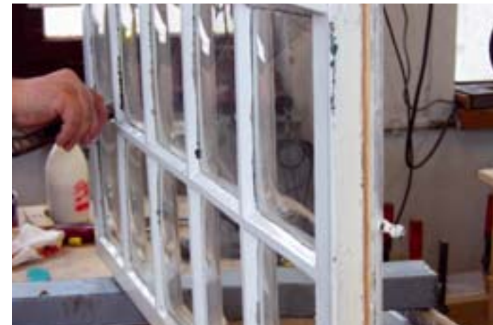
Um den energetischen sowie historischen Ansprüchen gerecht zu werden, wird die alte Verglasung gegen das neue Histo-Fine-8-Glas getauscht.
