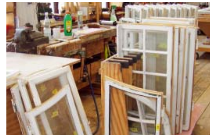
Die Stabilität und die Passgenauigkeit sowie die schadhaften Stellen am Fenster werden in der Werkstatt nochmals begutachtet und fachmännisch beseitigt.
